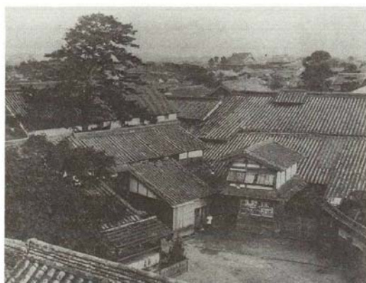
第24図 快哉楼よりみた飴屋本宅
