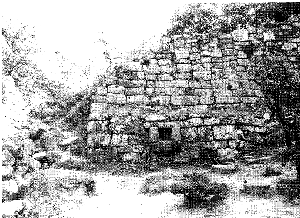
写真2 御所ヶ谷神籠石中門（水門）
